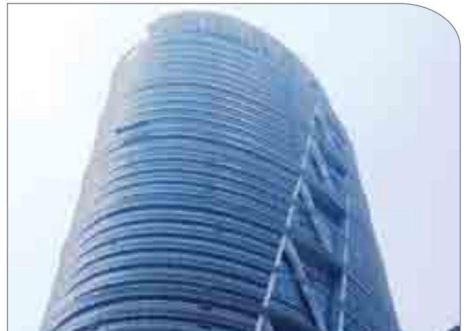
Menara FELDA, Platinum Park
